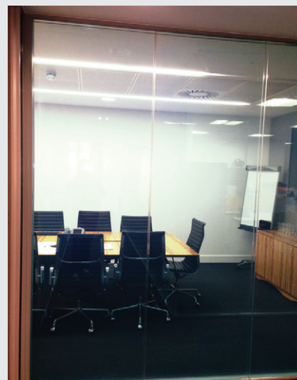
ESG Switchable™ w niebieskim szkle tint WŁĄCZONY
